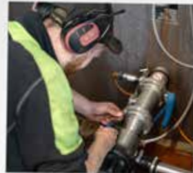
Serviceteknikern behövs för gårdens avancerade anläggningar.
